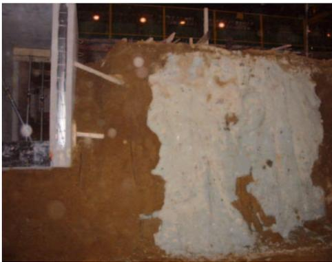
▲ *Massif de jet grouting sous une fondation*
