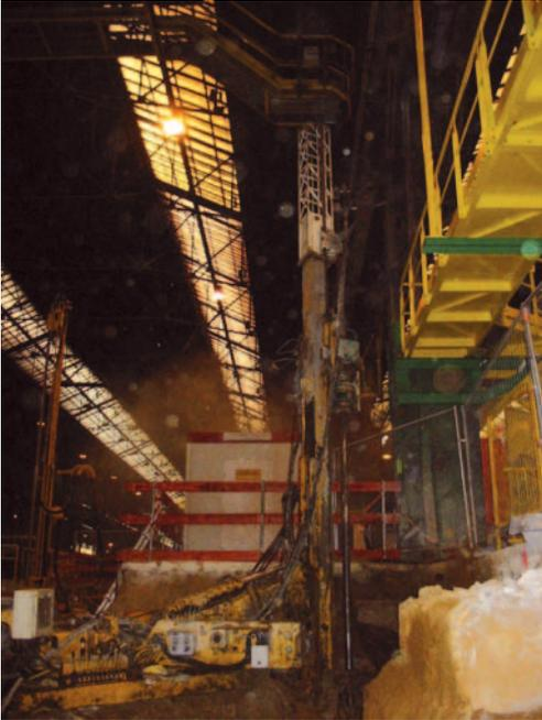
◀ Forage pour berlinoise dans l'encombrement de l'usine en exploitation
