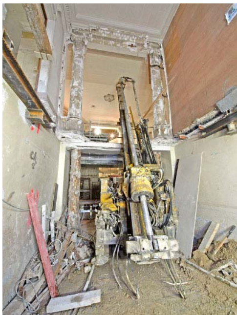
▲ Foreuse type KB 0 (fabrication Keller) utilisée pour ce projet
