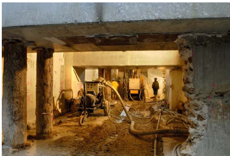
▲ Travaux réalisés sous poutres transfert (hauteur limitée)
