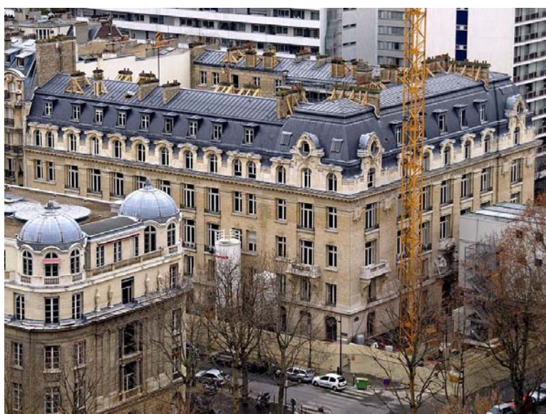
▲ L'immeuble en cours de rénovation (vue de la Tour Eiffel)
