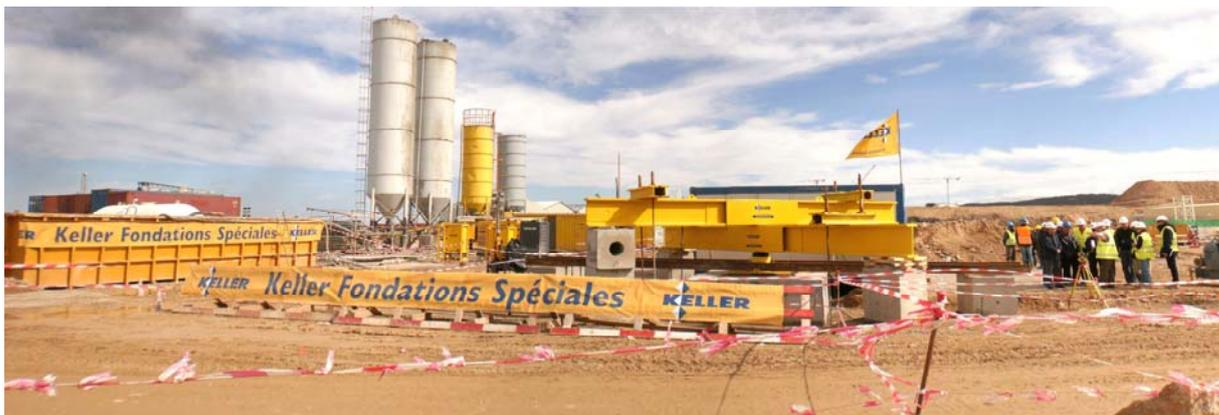
▲ Réalisation d'un essai de chargement sur massif de répartition (500 tonnes)
