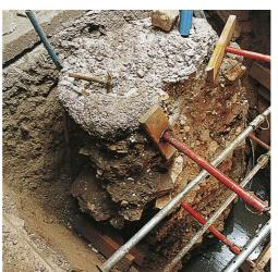
Colonne d'essai dégarnie
