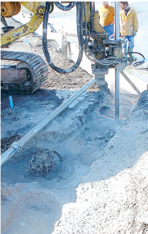
▲ Forage d'une colonne de jet grouting
