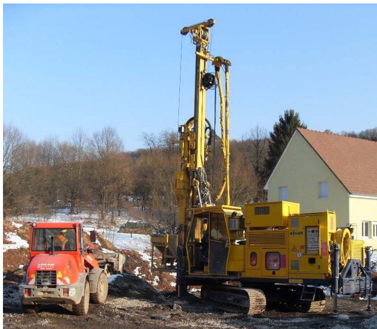
▲ Vue générale du chantier
