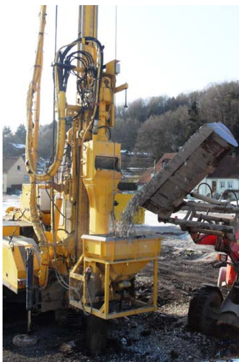
▲ Alimentation de la foreuse en ballast
