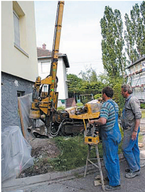
▲ Réalisation d'une colonne de CHS
