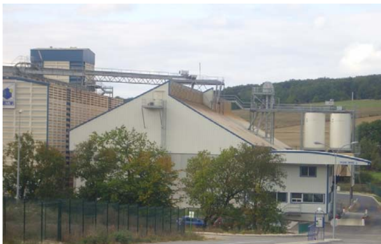
▲ Vue des bâtiments finis
