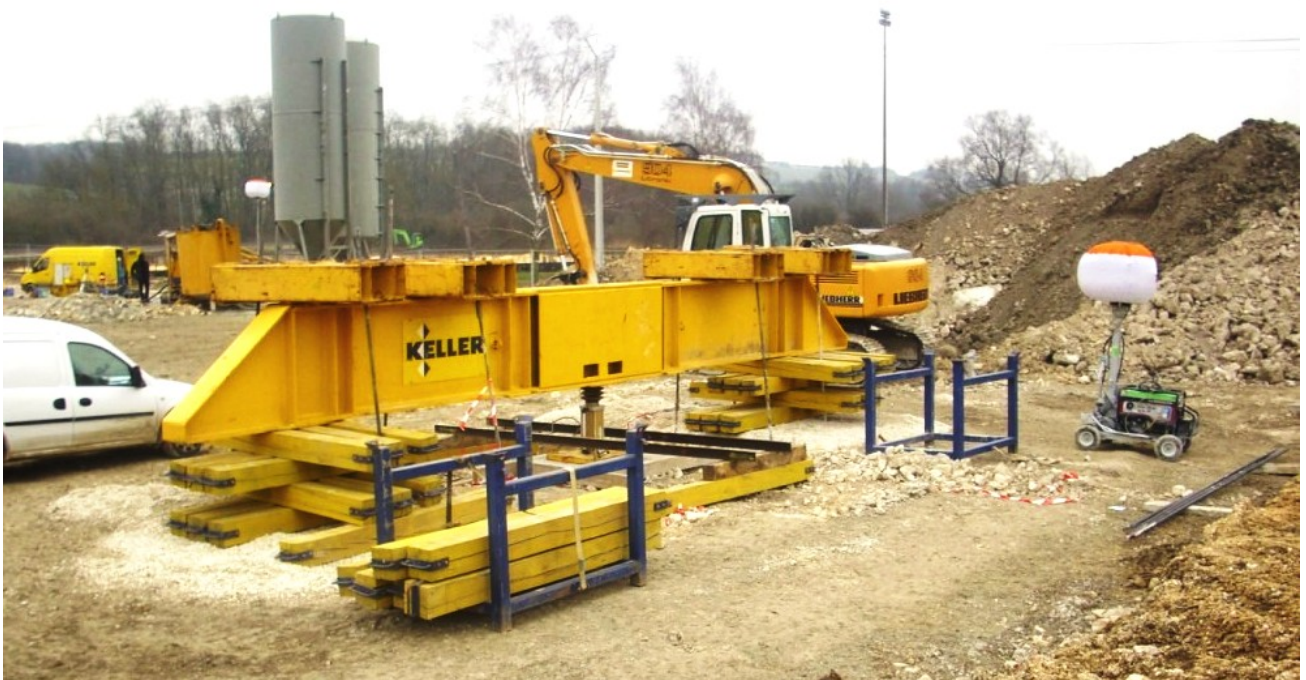
▲ Essai de chargement
