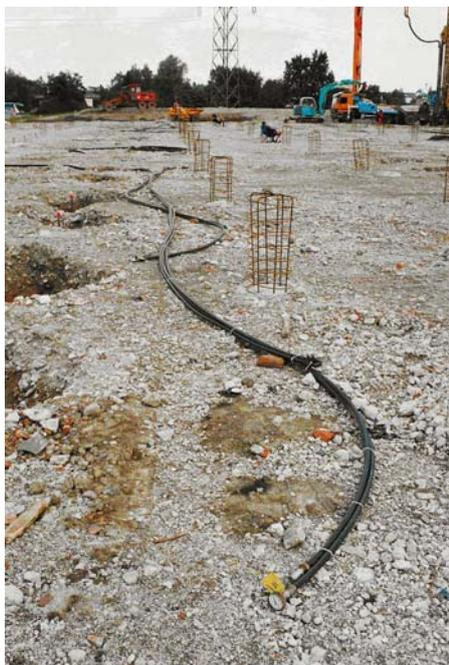
▲ Sondes thermiques avant leur mise en place
