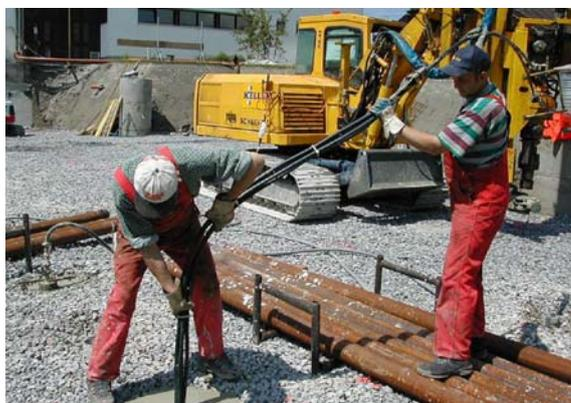
Tête de pieu MESI avec sonde thermique ►
