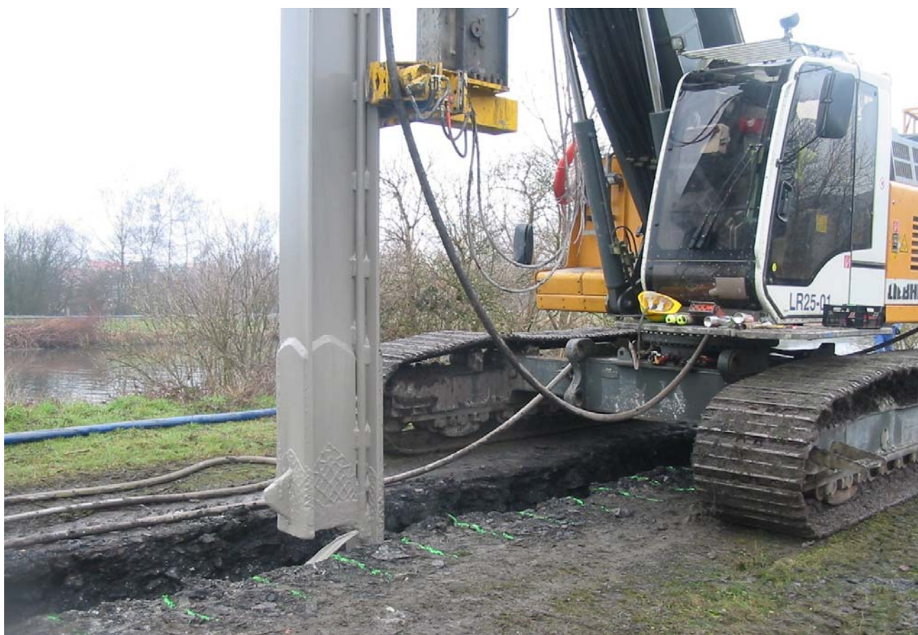
▲ Déplacement de la foreuse avant fonçage du profilé
