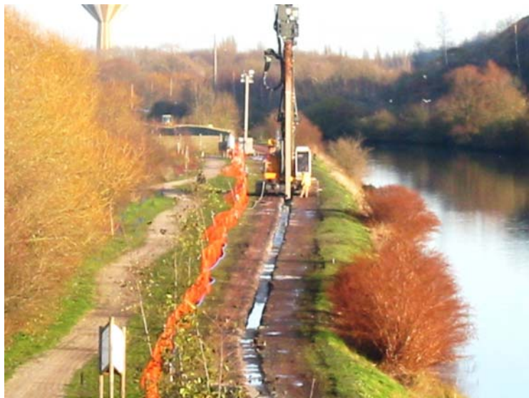
▲ Vue d'ensemble du chantier
