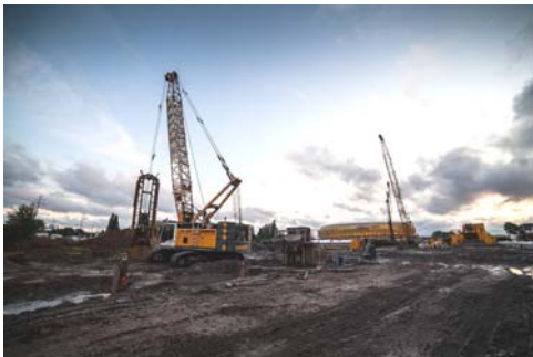
▲ Travaux sur la rive Ouest
