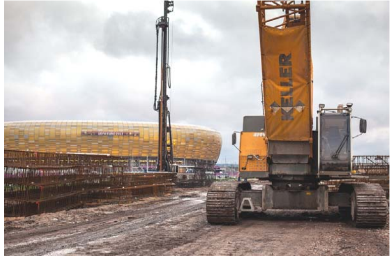
▲ Vue du chantier, à proximité du stade PGE Arena Gdansk
