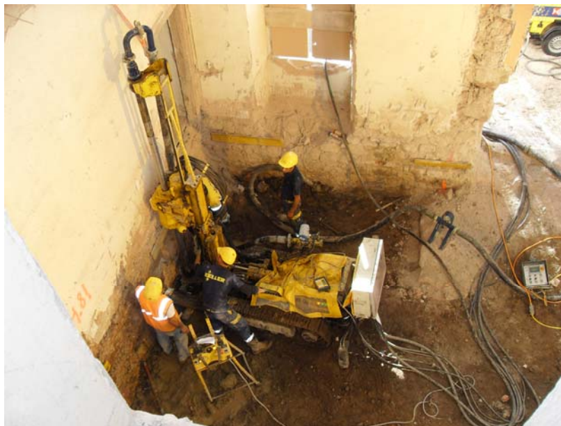
▲ Travaux CHS avec foreuse KBI
