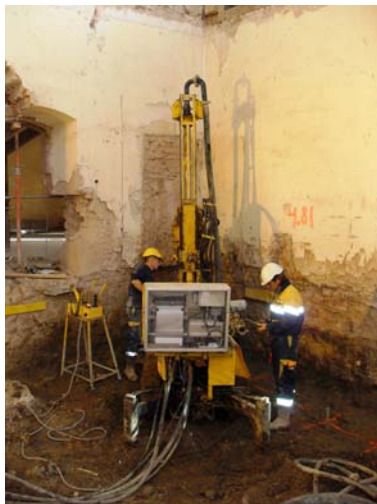
▲ Travaux en zone confinée
