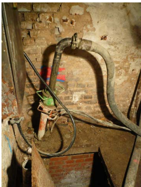
▲ Injection du mortier
