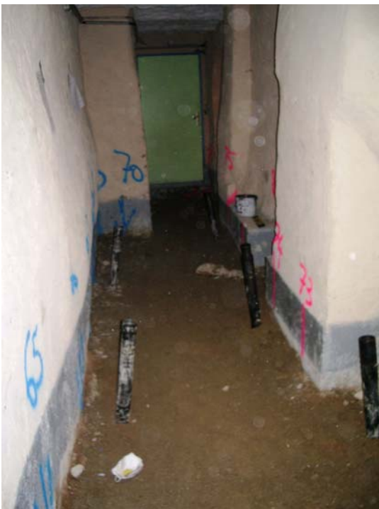
▲ Travaux en zone confinée
