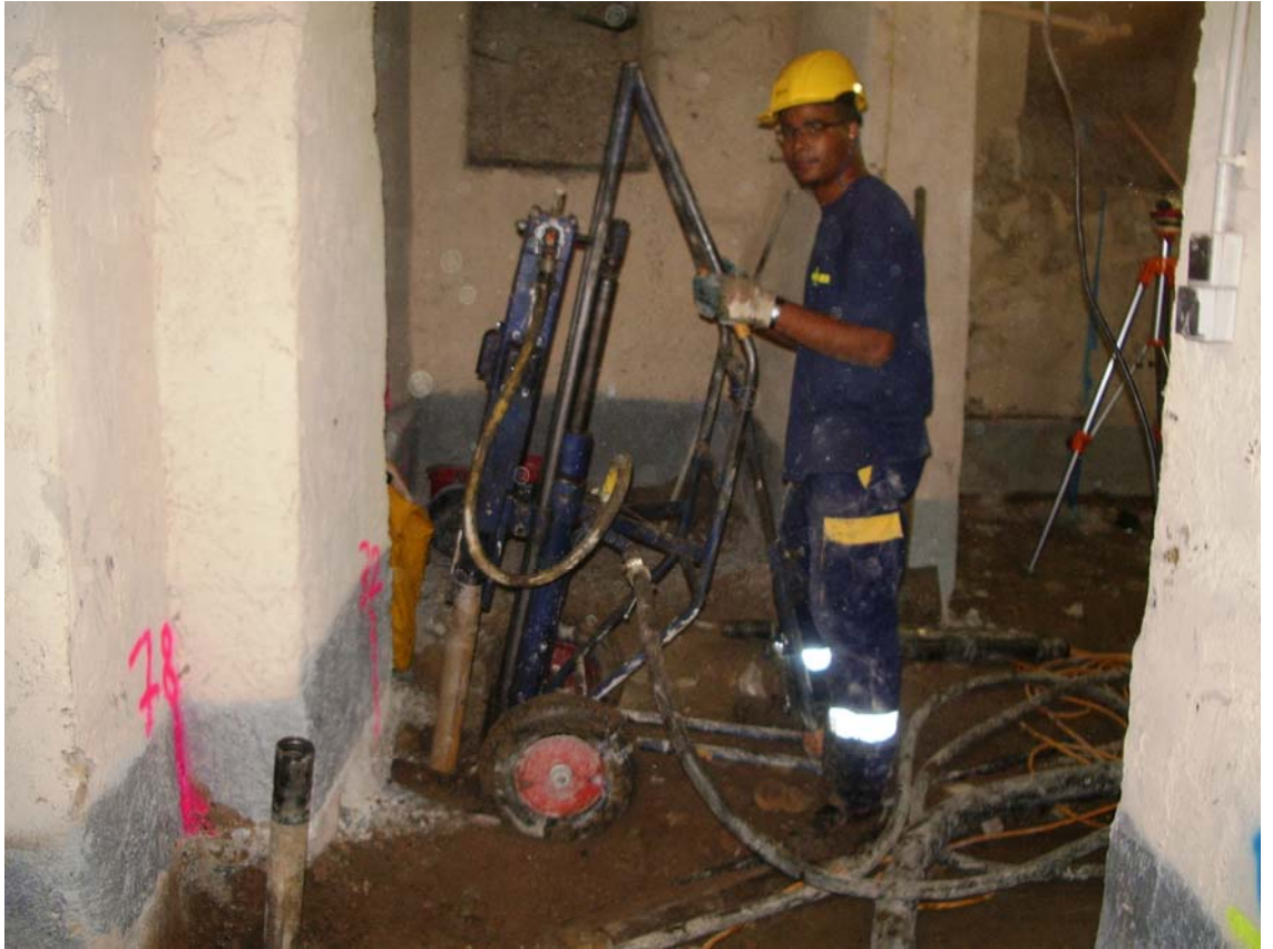
▲ Injection à la foreuse pneumatique type fusée IGEL
