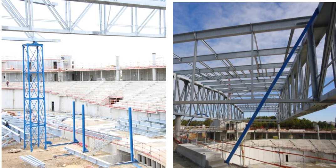
FIGURE 12 : QUELQUES SYSTEMES DE STABILITE PROVISoire
