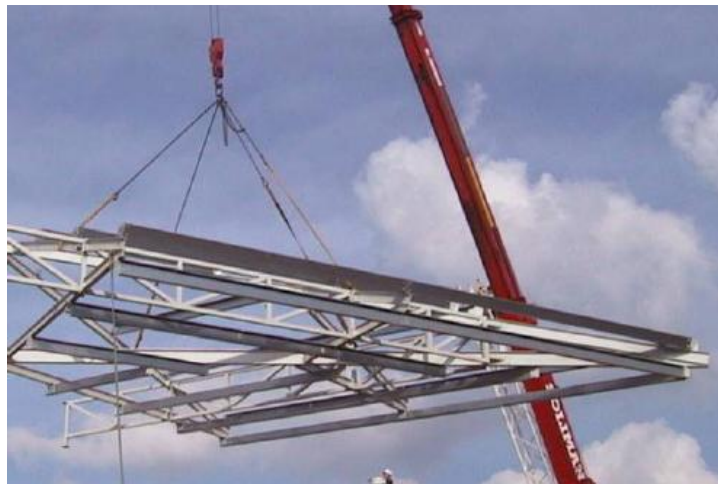
FIGURE 11 : ELEMENT ASSEMBLE AU SOL
