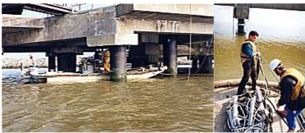
Figure 28 : protection des appontements par courant imposé. (Terminal Méthanier de Montoir de Bretagne)
