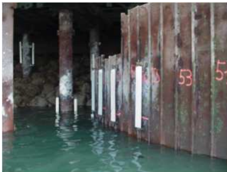
Figure 25 : cliché des anodes posées
