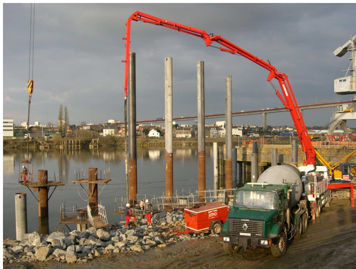
Figure 21 : chantier du quai poste 4
