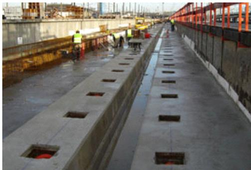
Afin d'obtenir la meilleure jonction entre les différentes phases de bétonnage, nous pouvons placer, en atelier, un fond en métal déployé à fine maille. Ceci évitera également le remplissage de la boîte par le fond lorsque sa hauteur est inférieure à l'épaisseur de l'ouvrage coulé.
