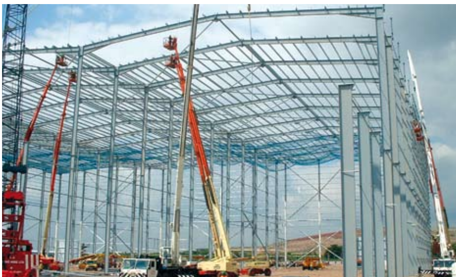
Figure 2.10 Processus d'installation d'un portique moderne Barrett Steel Buildings Ltd
