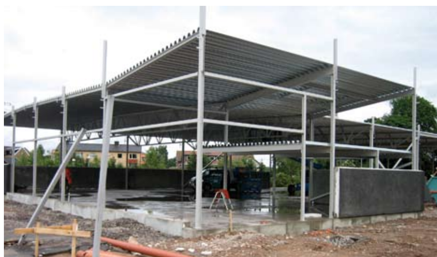
(Droite) Chantier de construction montrant la couverture et les planchers intermédiaires mis en place
