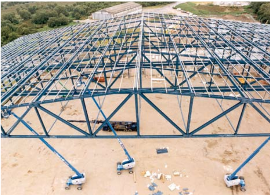
Figure 2.11 (Haut) Différentes formes de fermes à treillis utilisées dans les bâtiments industriels
