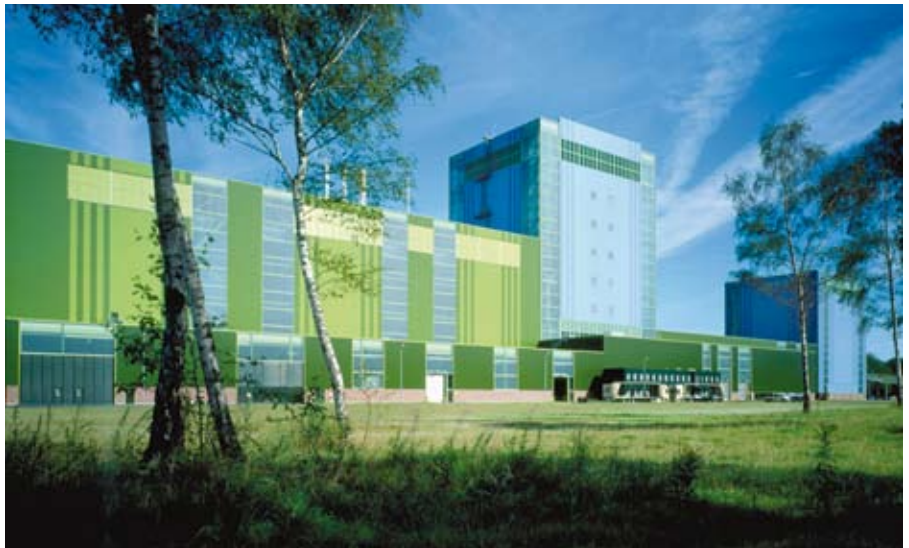
Figure 4.15 Bâtiment industriel à façade colorée. Source : www.tks-bau-photos.com
