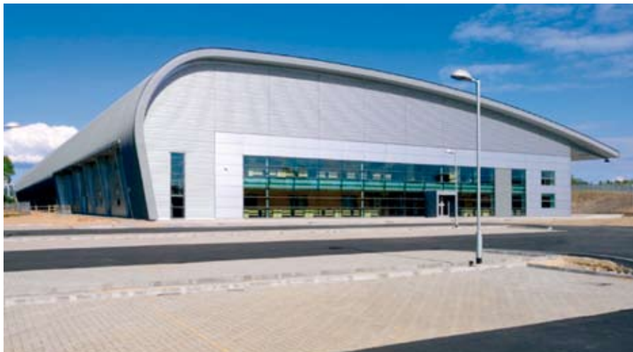
Figure 5.19 Profilés cintrés en acier utilisés dans un bâtiment industriel.
