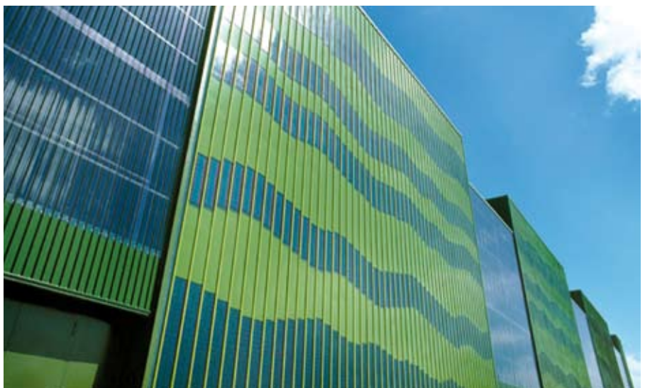
Figure 4.16 Façade avec panneaux solaires intégrés. Source : www.tks-bau-photos.com
