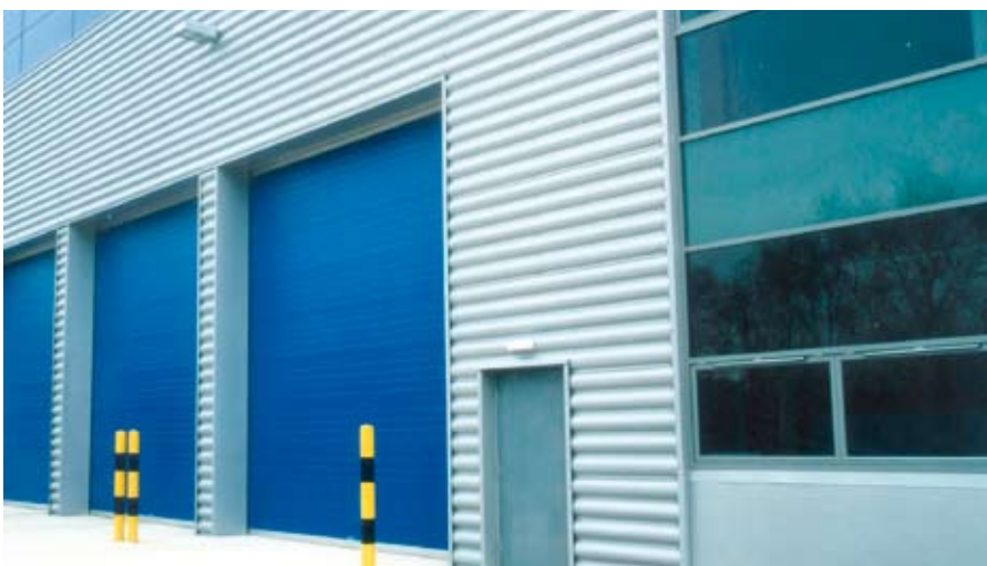
Figure 4.9 Panneaux mixtes positionnés horizontalement
