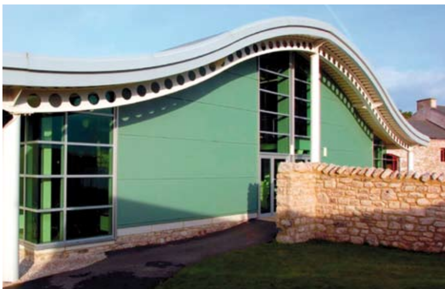
Figure 5.20 Poutres cellulaires cintrées destinées à un centre de loisirs
