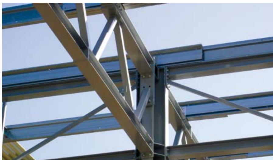
Figure 5.3 Pour des portées plus longues, les poutres à treillis constituent une autre solution courante
