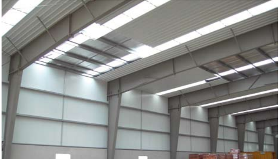
Figure 5.10 Structure intérieure d'un bâtiment industriel avec poteaux de section décroissante
