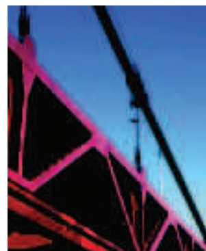
Poutre triangulée dans un pont suspendu (ici le Golden Gate à San Francisco).
