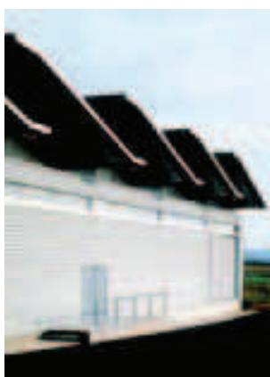
Bardage à ondes horizontales en acier prélaqué. Atelier-relais à Chanteloup-les-Vignes. C. Lauvergeat et P. Cremonini architectes.
