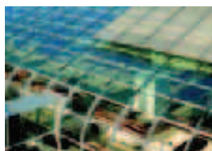
Pose de la toiture brise-soleil sur la péninsule du Hall 2F à l'aéroport de Roissy, France. P. Andreu/ADP architectes.
