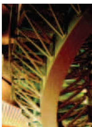
Structure en acier d'un escalier aux marches en verre. Hôtel de ville de Gauchy. É. Dubosc et M. Landowski architectes.
