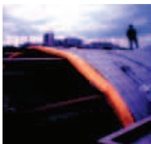
Pose d'une toiture chaude cintrée.
