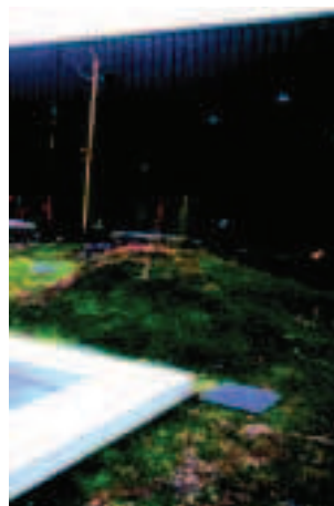
Toiture-terrace attenante à la chambre d'enfant située à l'étage. Maison métal de la Villette, G. Hamonic et J.-Ch. Masson architectes.
