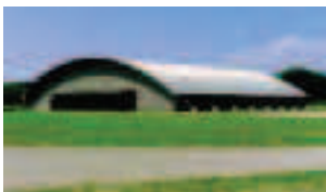
Parement métallique à quatre ondes asymétriques en couverture. Salle omnisports de Saint-Maurice-l'Exile, France. F. Devigne architecte.
