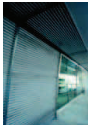
Parement à ondes sinusoïdales obtenu par le pliage de tôles en acier. Aéroport de Bordeaux, France. Luc Arsène-Henry architecte.
