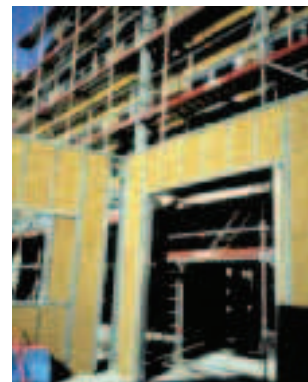
Montage d'une façade légère composite avec isolant en laine de roche.
