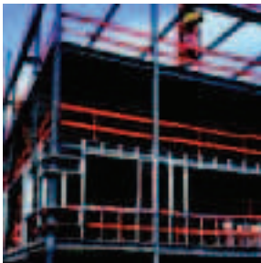
Façade légère en cours de montage.
