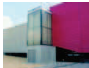
Bardage de tôle laquée. Miracle Planet Enschede, Pays-Bas. I/AA architectes.
