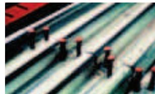
Bac acier avec connecteurs soudés au droit des solives.
