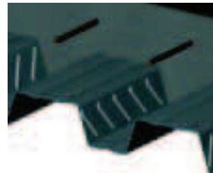
Bac acier collaborant de type Cofraplus à profil trapézoïdal ouvert muni de bossages.
