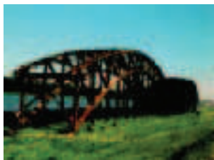
Démontage du pont de Hammer à Düsseldorf, Allemagne.
