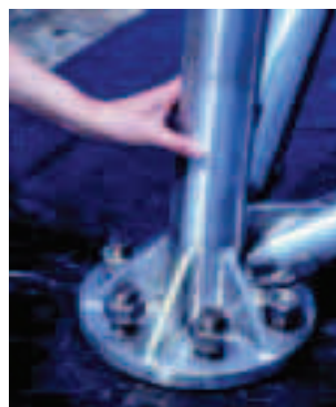
Pied de poteau mécanosoudé.
