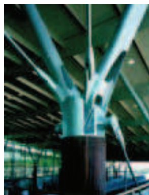
Pièce moulée pour les poteaux de la gare TGV du plateau d'Arbois, près d'Aix-en-Provence, France.
