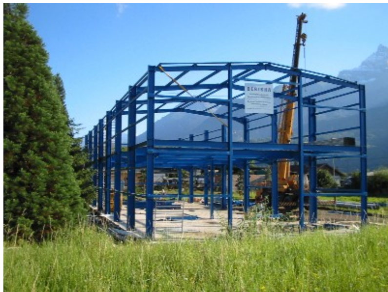
Photo : Une grue mobile
