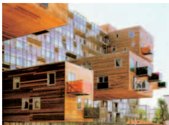
Une charpente en acier se cache derrière un revêtement en bois. MVRDV: Logements pour personnes âgées, Amsterdam, 1997
