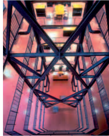
Contreventement vertical d'un immeuble à 8 étages, Arcelor à Esch (Luxembourg)
