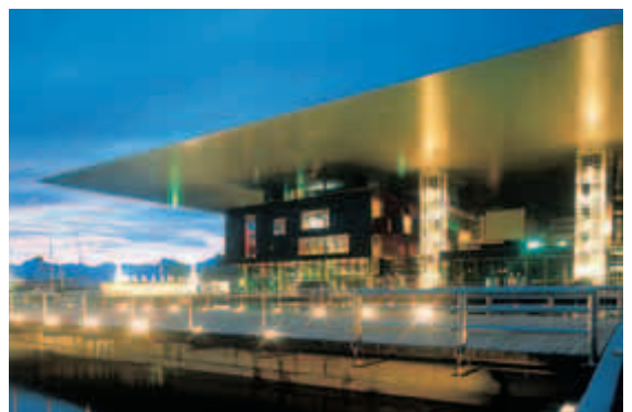
Centre de culture et de congrès à Lucerne (Jean Nouvel), 1999. Porte-à-faux: 35 m, en diagonale: 45 m. Hauteur des poutres: 3,7 m au maximum.
