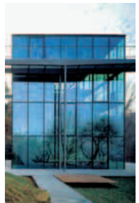
Maison Sobek: ossature en acier composée de poteaux en profilés creux carrés et de poutres IPE, Stuttgart 2001
