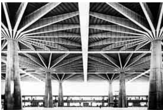
Champignon en béton et acier; surface couverte de 38 m x 38 m. Pier Luigi Nervi: Hall of Labor, Turin, 1961
