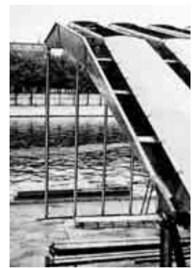
Détail de la structure et illustration. Jean Prouvé: Pavillon du centenaire de l'aluminium, Paris, 1954
