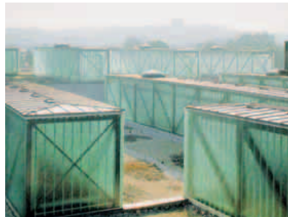
L'éclairage zénithal va de mur à mur. Revêtement en verre Profilit. Herzog & de Meuron: Dépôt de locomotives auf dem Wolf, Bâle, 1995
