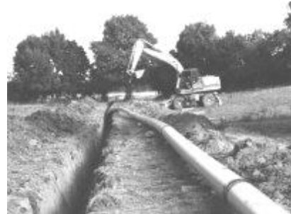
[FIG.2] CHANTIER DN1000
