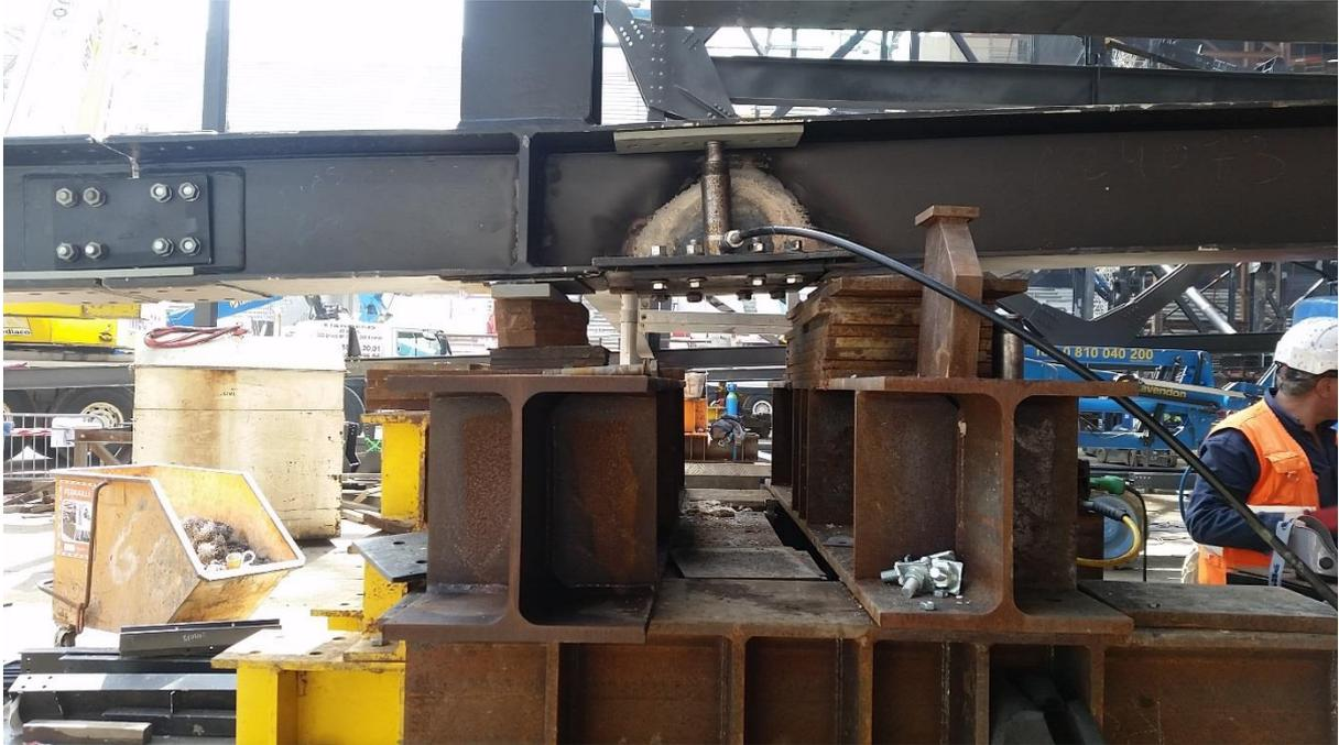
*Figure 30 : Dressage de l'âme en utilisant des vérins.*
