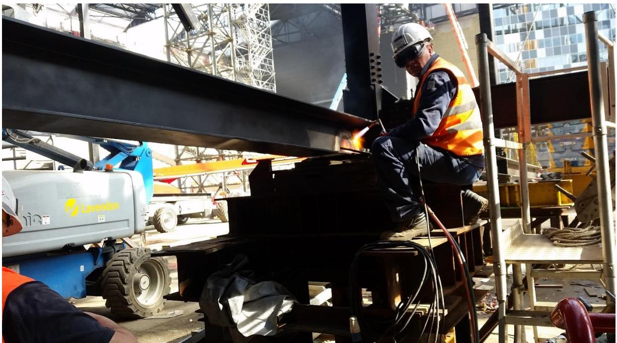
**Figure 29 : Chauffage de la partie enfoncée**
