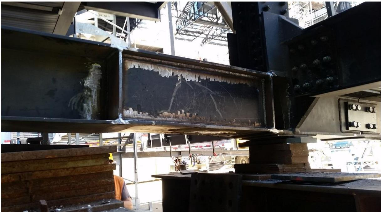
*Figure 31 : Renfort de l'âme par des caissons (des 2 côtés).*
