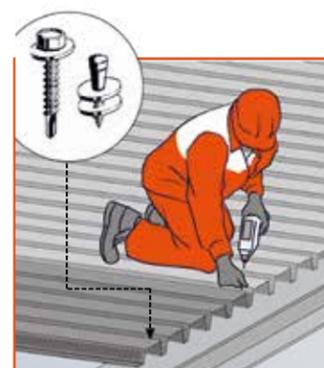
14 - Fixer les profils sur les appuis et les coutrer entre eux (2 fixations par profil et par appui)
