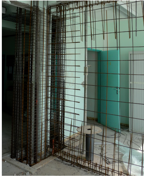
Exemple de renforcement parasismique
