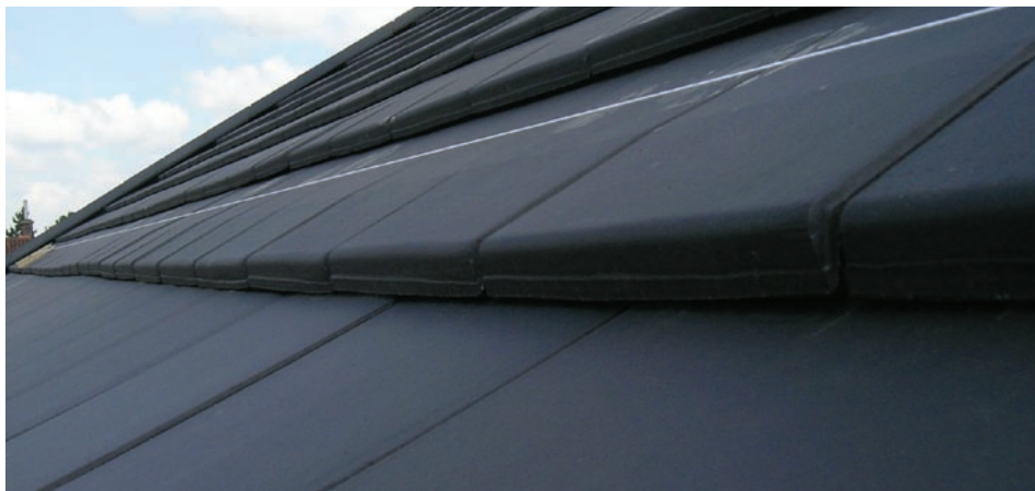
Fig. 3 Mesure de la flèche d'une couverture.
