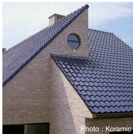
Fig. 2 Tuiles correctement posées.
