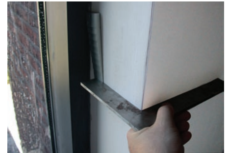
Fig. 1 Contrôle de l'équerrage.
