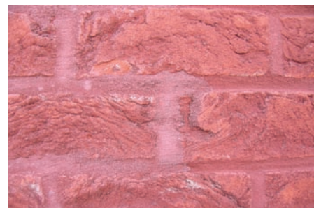
Fig. 3 Variations de teinte sur les joints.
